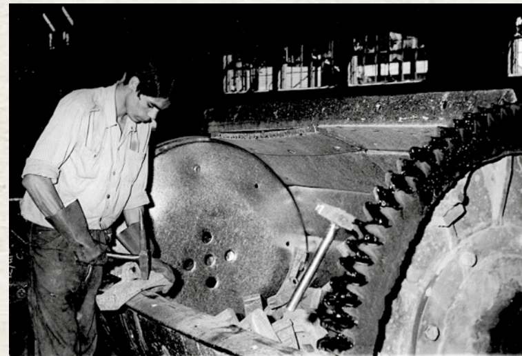
Fabricación de zapatas de freno de ferrocarril en el taller de fundición de la Maestranza de San Bernardo.
