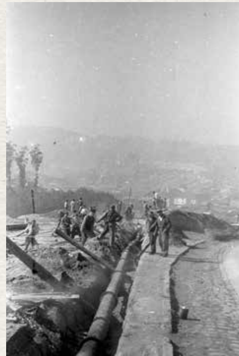
Faenas de instalación de la red de agua potable, desde Colcura hacia Lota Alto, dañada a causa del terremoto de 1960.
