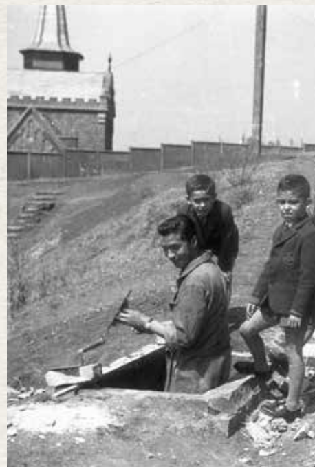
Raúl y Guillermo Herrera observando al maestro albañil que construye una cámara para la instalación de la red de agua.
